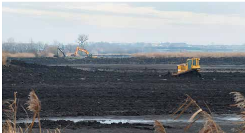
PROCEDURY ZWIĄZANE Z REMONTEM STAWÓW, NA SZCZĘŚCIE, NIE SĄ TAK RYGORYSTYCZNE JAK TE DOTYCZĄCE BUDOWY NOWYCH OBIEKTÓW | FOT. JAROSŁAW CZERWIŃSKI/ ARCHIWUM
