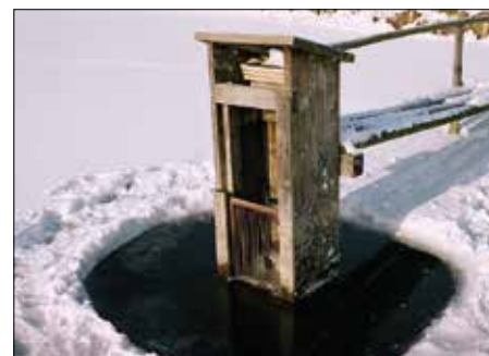
Zimą trzeba odkuwać mnichy, aby pokrywa lodowa nie uszkodziła stojaka mnicha. | Zdjęcia: Mieczysław Stec
