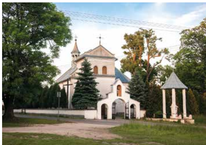
KOŚCIÓŁ POD WENIEBOWZIĘCIĄ NAJŚWIĘTSZEJ MARII PANNY to chluba Potoka. Murowaną jednonawową świątynię wybudowano w latach 1647-1648. Jej najcenniejszym elementem wyposażenia jest barokowa ambona z 1678 roku zdobiona scenami biblijnymi.
